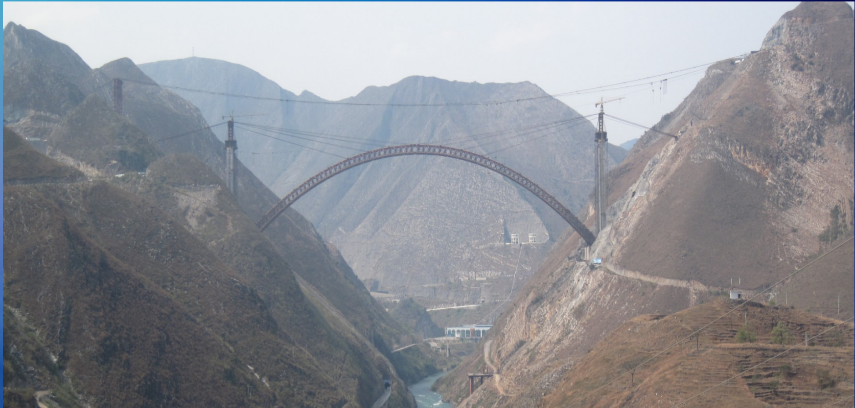
建设中的拱桥（主桥为跨度445m上承式钢筋混凝土拱桥）
