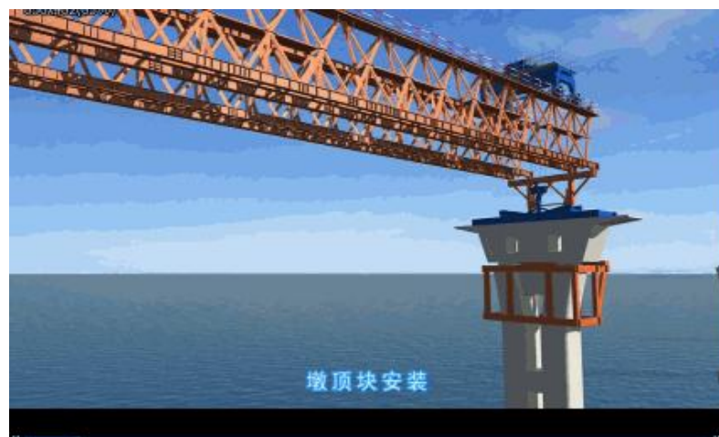
梁段安装技术和跨中段合龙技术
