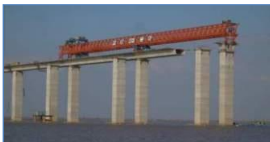
苏通大桥非通航孔桥 (国内首次大规模采用)
